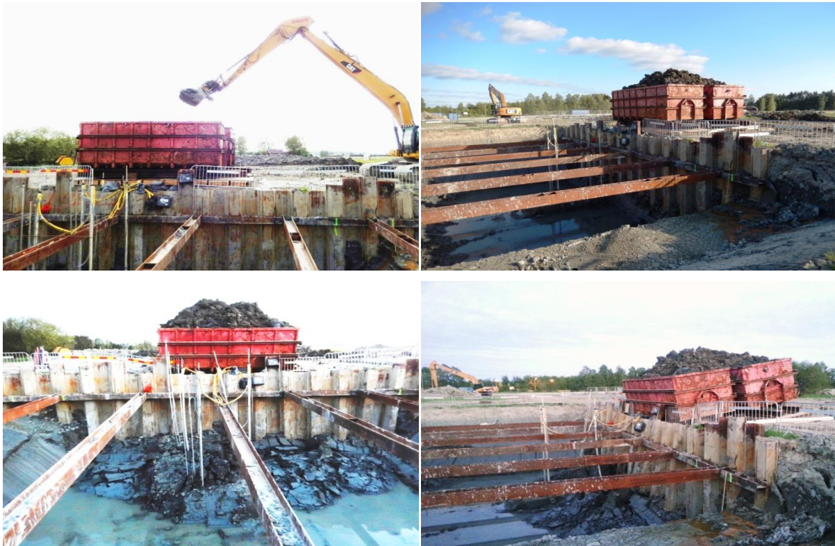
Figur 8: Belastning och brott för Test 1
